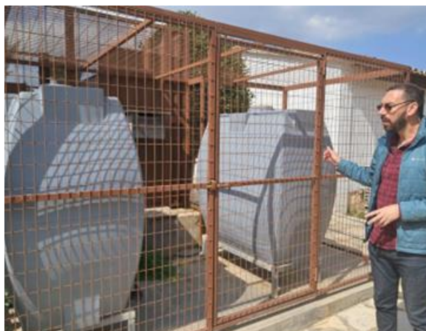
Ο Δρ. Γιώργος Φυττής, λειτουργός του ΚΠΕ Αθαλάσσης μας εξηγεί τον τρόπο λειτουργίας ενός συστήματος ανακύκλωσης γκρίζου νερού.
